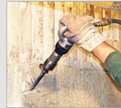
Problemfri fjerning av gammel murpuss og fliser
