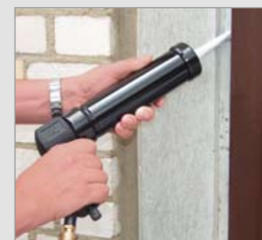
Sprøyting - fugene fylles uten søl
